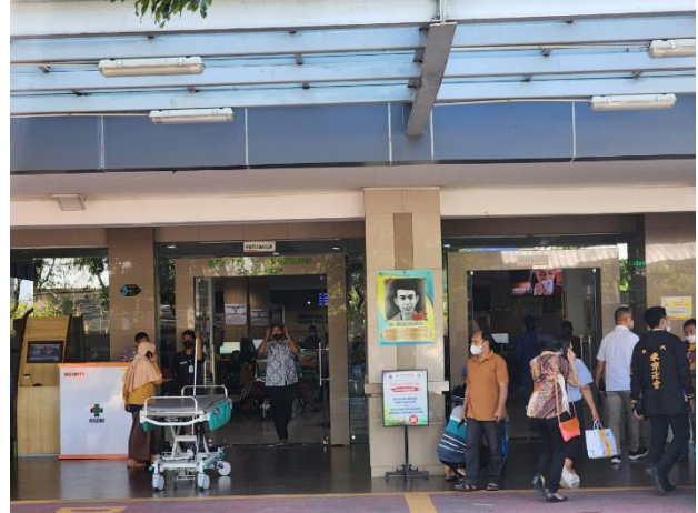
Pintu Masuk Gedung Wijaya Kusuma Lantai 1
