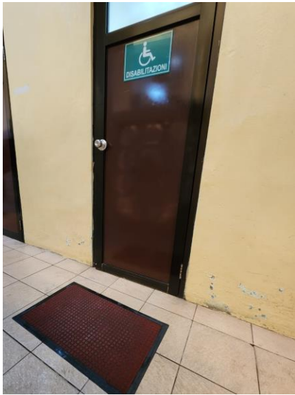
Keset di Toilet Khusus Disabilitas di Wijaya Kusuma Lantai 1
