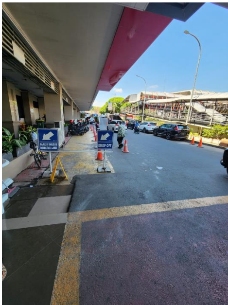
Parkir Khusus Disabilitas di depan Gedung Wijaya Kusuma
